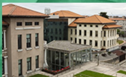
Pabellón 21 desde la antigua residencia de enfermeras, 2023
