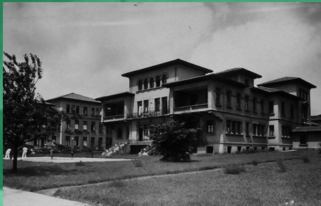
Pabellón 16, en cuya segunda planta se encontraba la residencia de enfermeras, actual Biblioteca Marquesa de Pelayo
