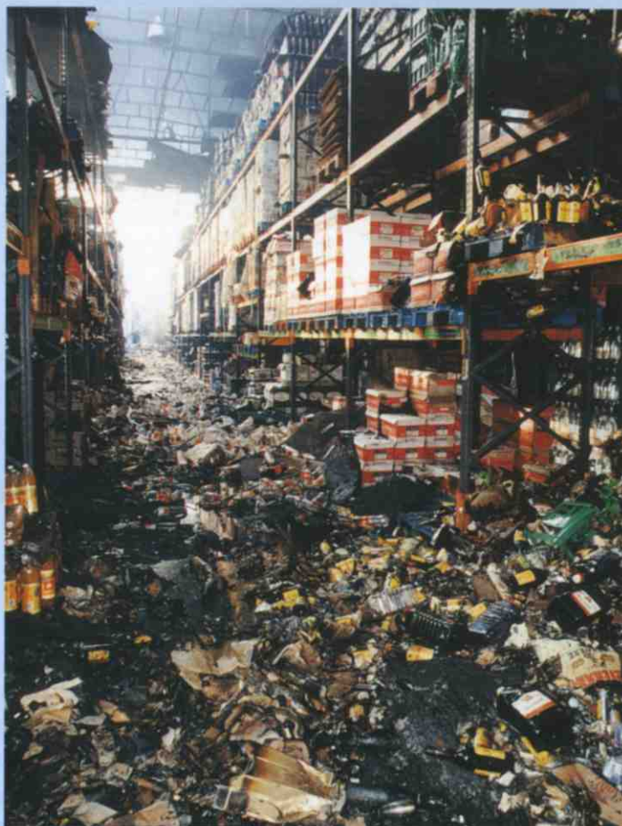
El almacén de la Cooperativa Alcosant quedó totalmente destruido a causa de un incendio.
