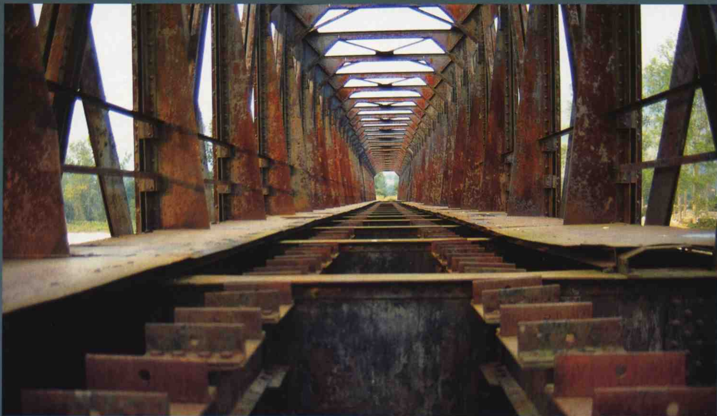
● Puente sobre el río Pas, en la antigua línea Astillero-Ontaneda.
