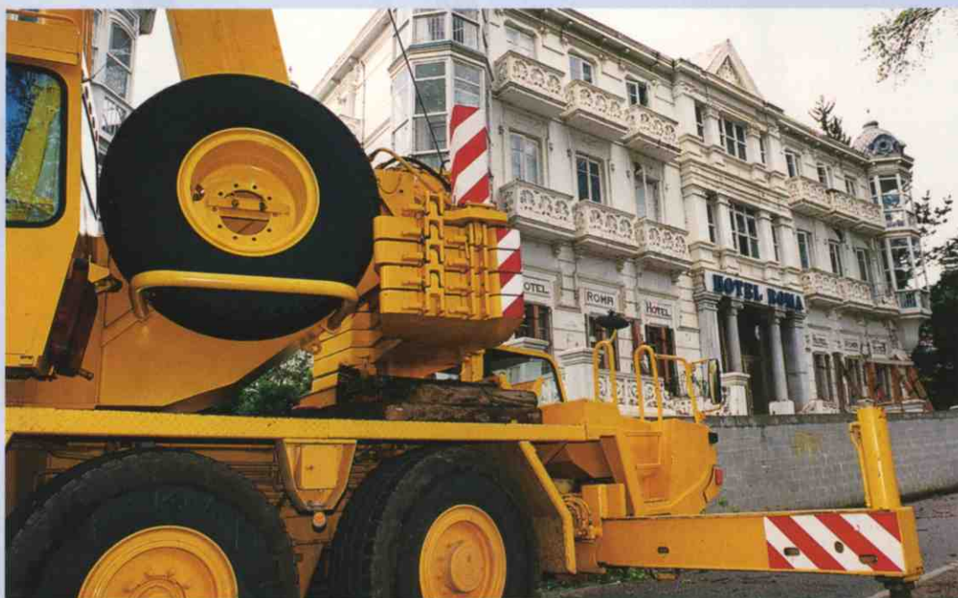
El Hotel Roma fue definitivamente demolido.
