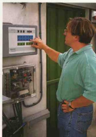
**En la página anterior, dos técnicos del SERCA revisan la plantación de pino piñonero. En esta página, de arriba a abajo, planta de pino silvestre, de dos años; laboratorio móvil para analizar la salinidad y acidez del agua y del sustrato; y panel de control automático de riegos mediante apertura y cierre de electroválvulas.**
