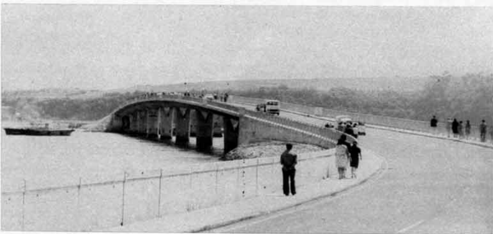
Queda abierto al tráfico el puente Pedreña-Somo.
