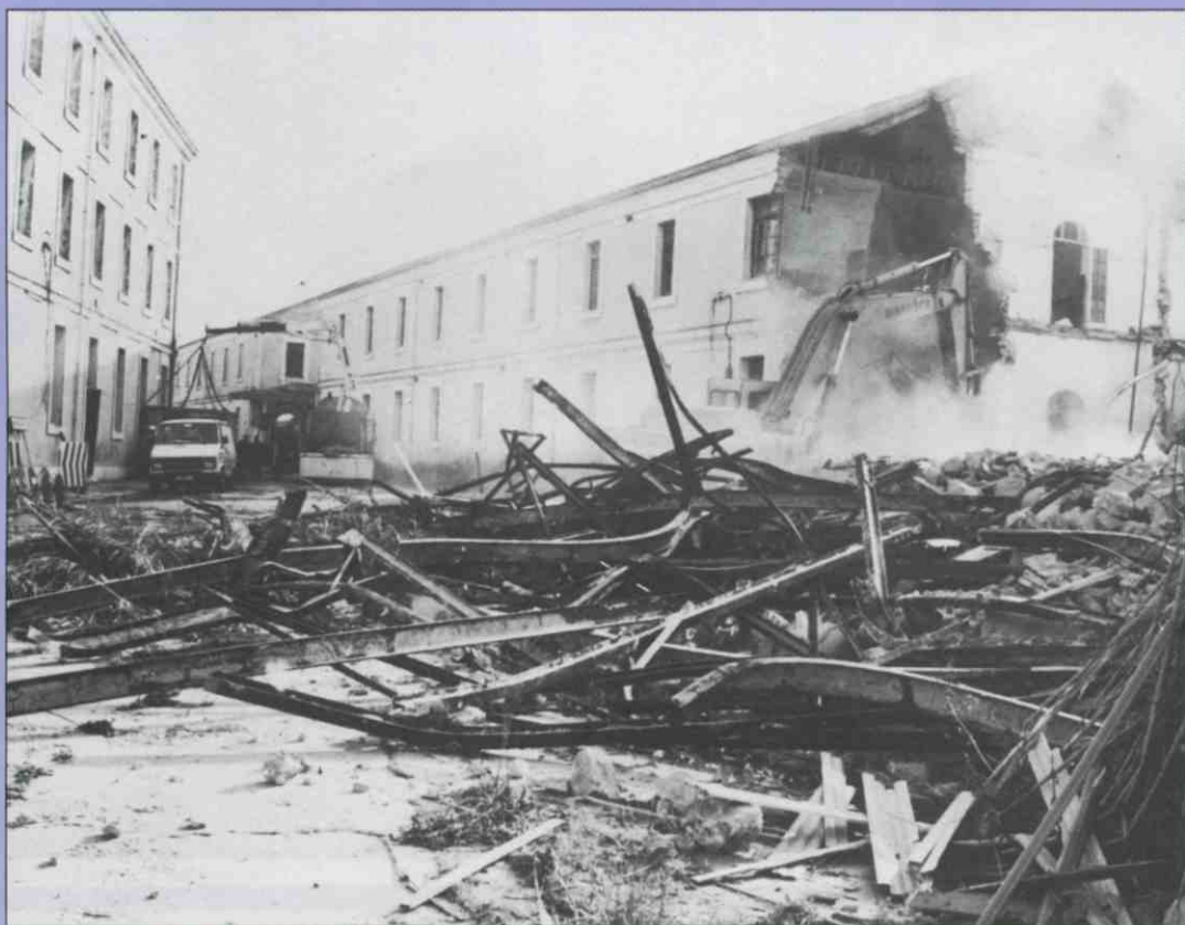
Demolición del cuartel de María Cristina.
