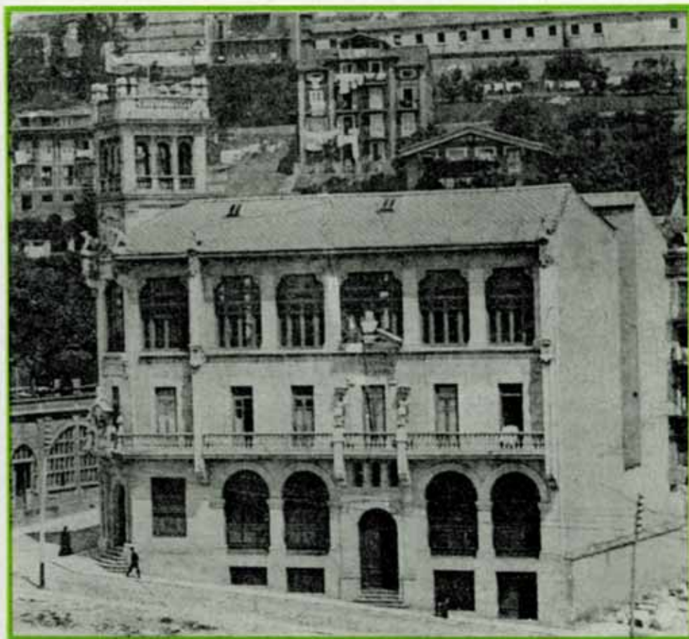
El edificio del Monte de Piedad y Caja de Ahorros, inaugurado por don Alfonso XIII en 1907.
