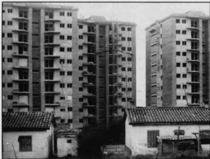
Las viviendas sociales que levanta el municipio en terrenos de La Albericia.
