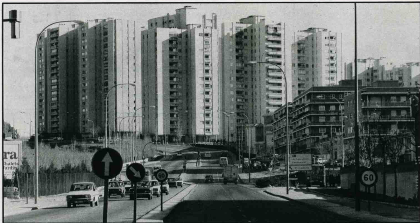
La avenida del Cardenal Herrera Oria, antes denominada carretera de la Playa, se encuentra hoy poblada, a uno y otro lado, por urbanizaciones nuevas y por zonas residenciales.
