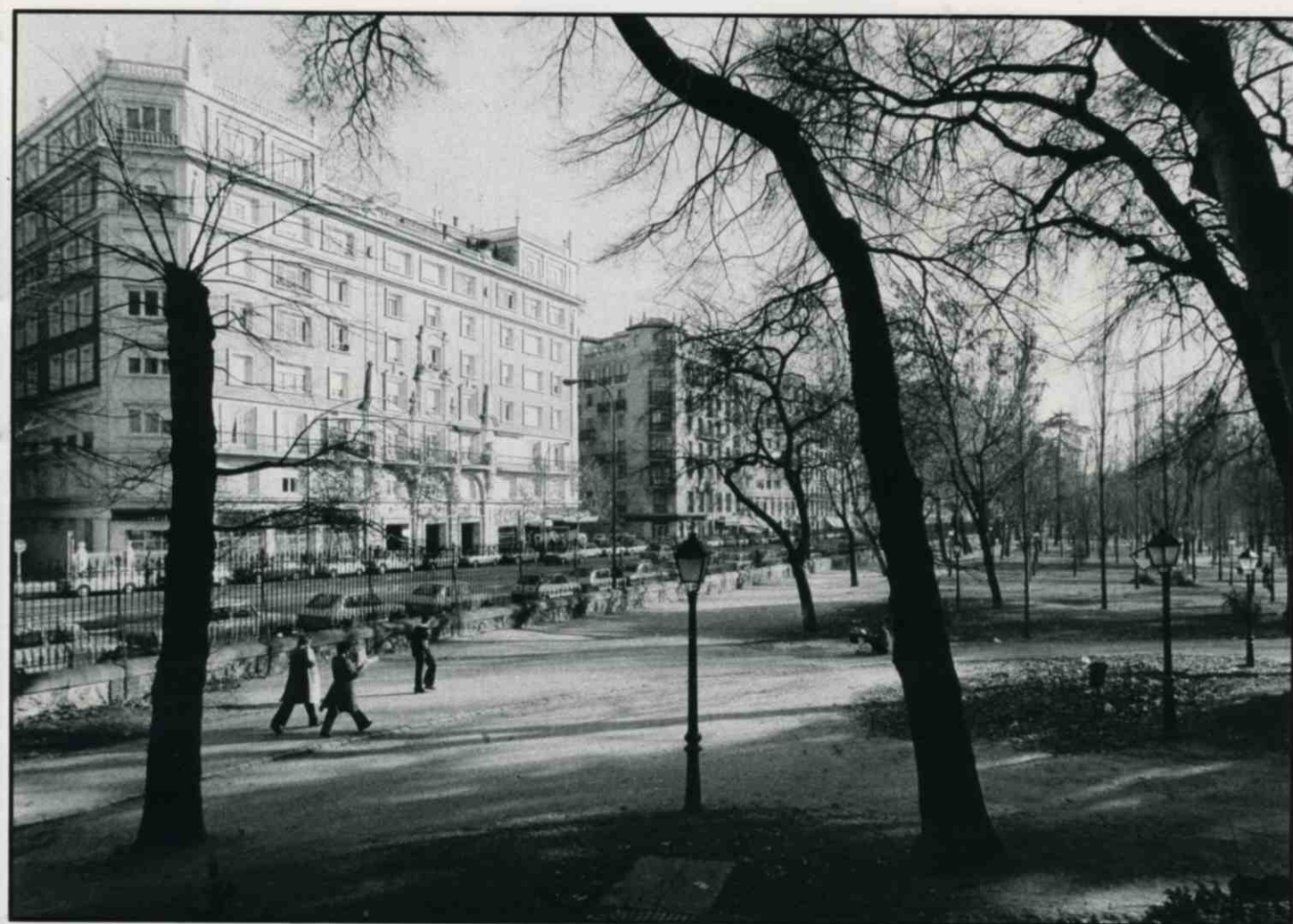
El parque del Retiro limita la acera izquierda de la avenida de Menéndez Pelayo.
