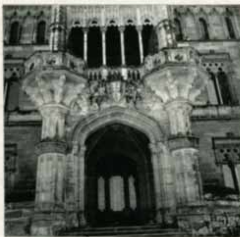
Fachada principal del palacio de Sobrellano. A la derecha, a toda plana, una vista de la loma Cardosa, característica por la serie de edificios que coronan su cresta.
