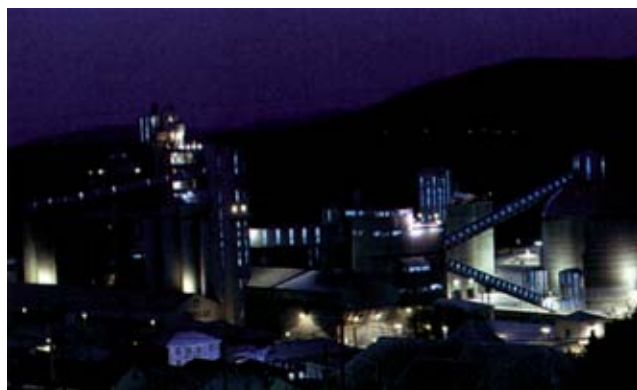
Vista nocturna de la fábrica de cementos. A la derecha, el pasado industrial de Valdeolea siempre estuvo vinculado al ferrocarril.
